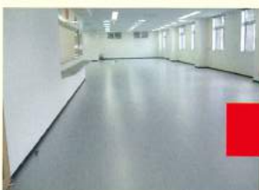
床材リノリウム 施工前
