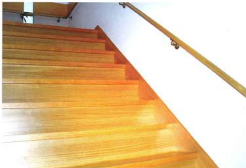
(階段及び手摺) 滑り止め転倒事故防止
